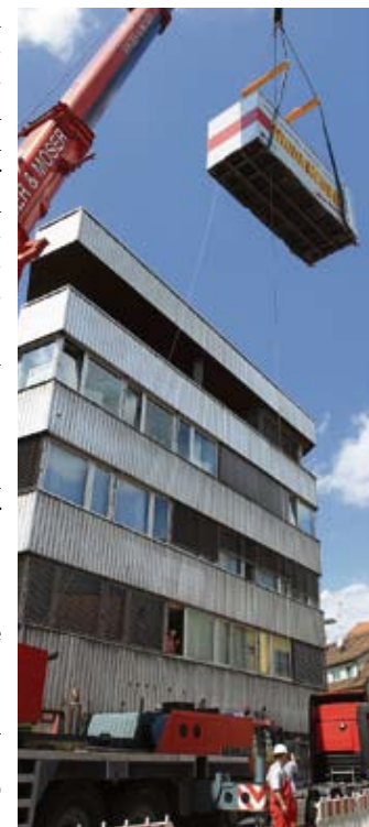
Mittels Kran wurde im Juli der neue Kernspintomograph in die Praxis in der Bergstraße 13 gehievt.
